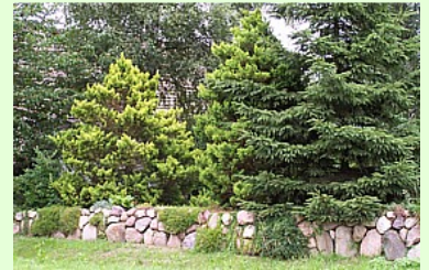
Regionale Bauart: Die Findlingsmauer
